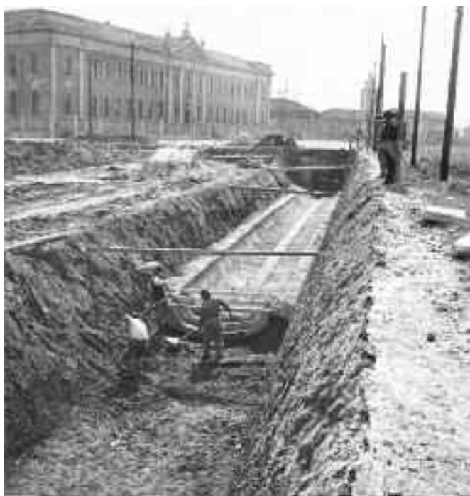
Costruzione del collettore di via Monluè, quartiere Forlanini
